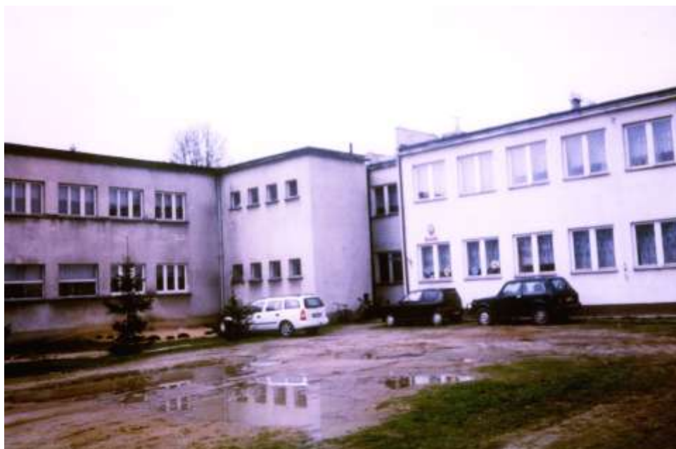
Budynek szkolny wraz z dobudowanym skrzydłem – strona północna
