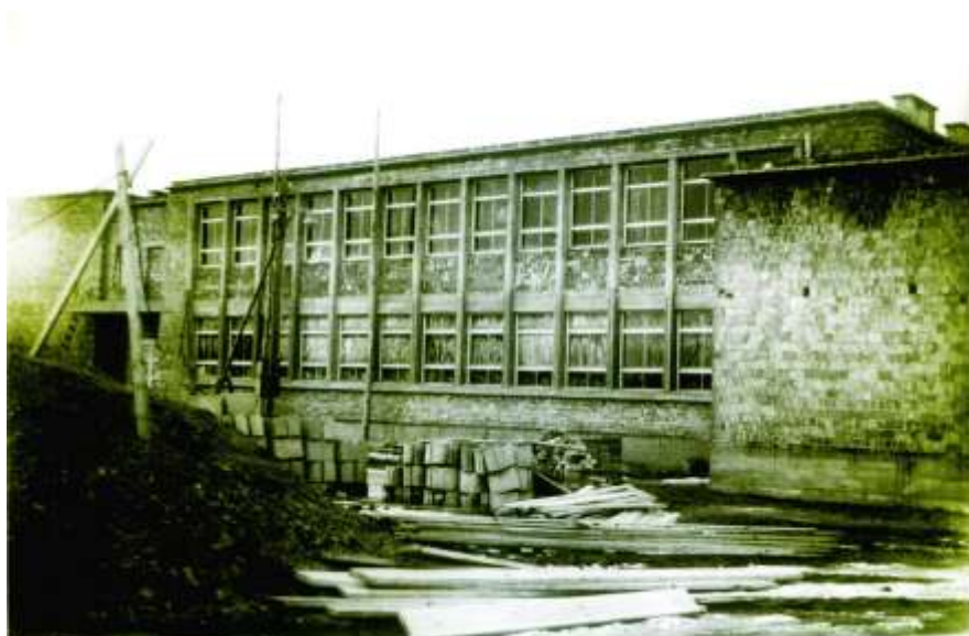
Nowa szkoła w budowie, luty 1963r.
